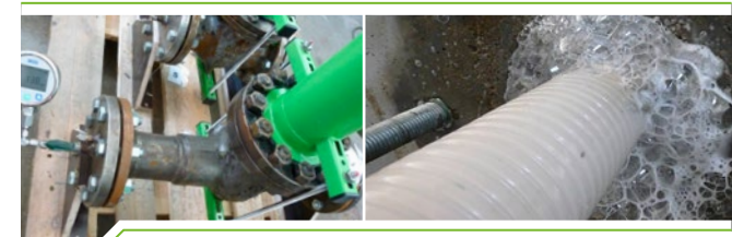
Dichtheitsprüfung unter Realgas und an einer Wanddurchführung (v.l.n.r.)
